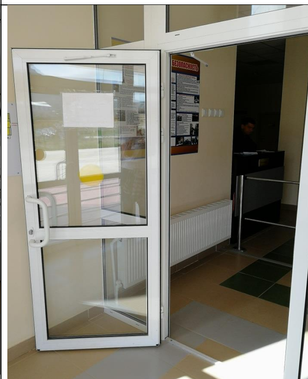
Фото № 16 - Вход в здание. Тамбур. Дверь
