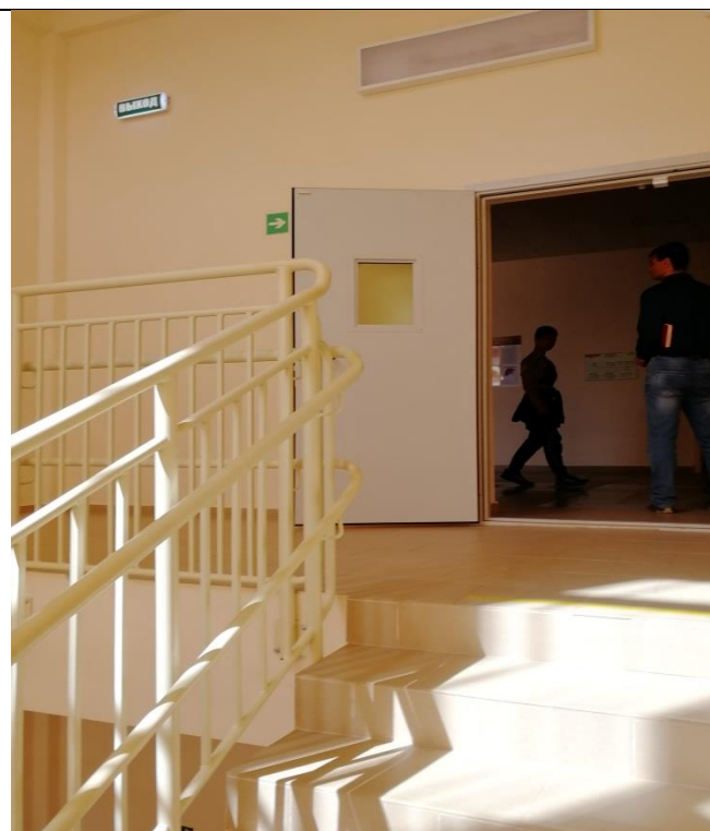
Фото № 26 – Межэтажная лестница
